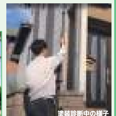
塗装診断中の様子
